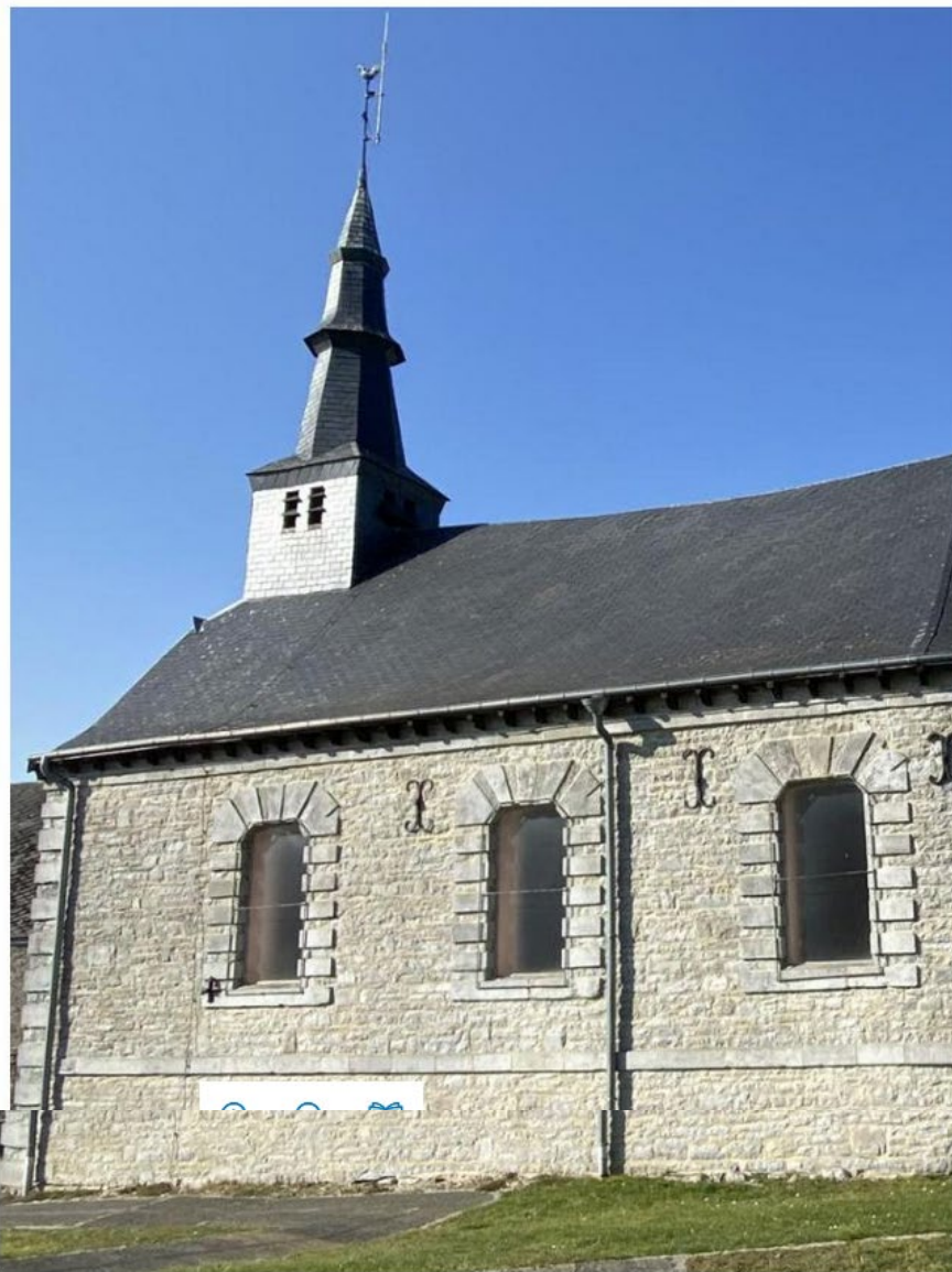
Les travaux de réhabilitation de l'église de Foisches sont estimés à 101 000 €. Archives
